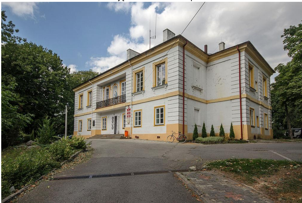
Zdjęcie 21: Pałac w Słupi
